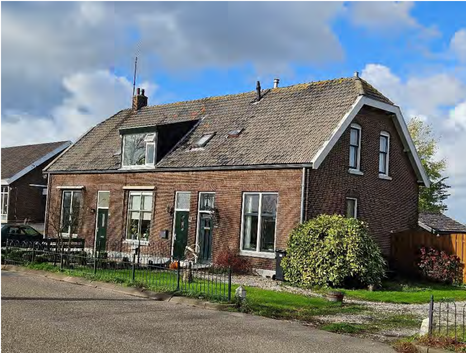
Figuur 3-7 Bebouwing (Gnephoek 6-10) met potentiële nestlocaties voor huismus en gierzwaluw in het plangebied.
